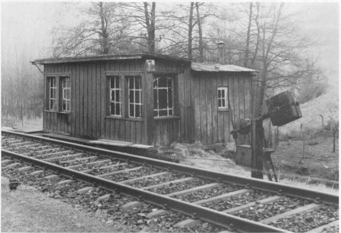
Stellwerk in Wehr (Baden) (Foto: Gerber)
