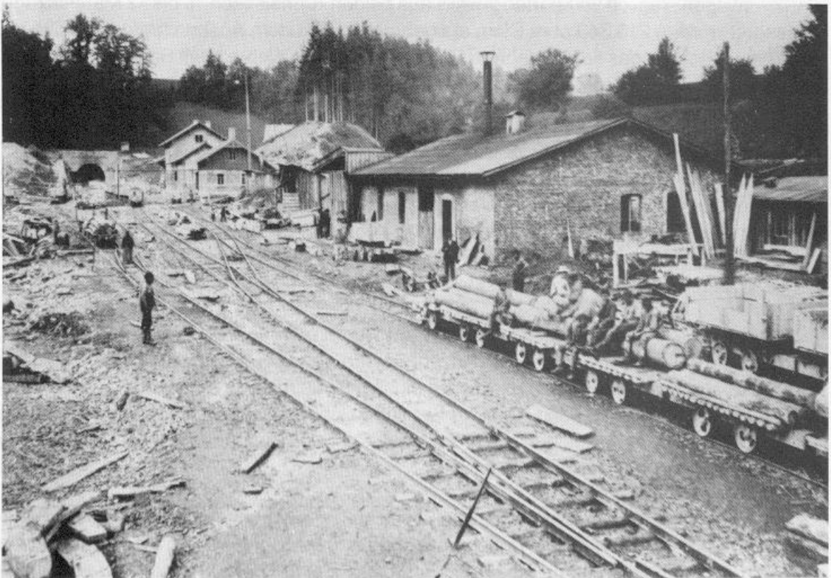
Bau des Tunnels in Hasel 1889; Foto: Archiv Stadt Wehr
