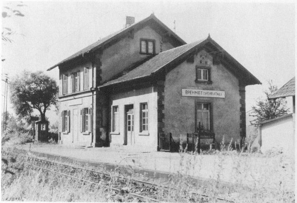
Bahnhofsgebäude Brennet/Wehratal (Foto: Gerber)
