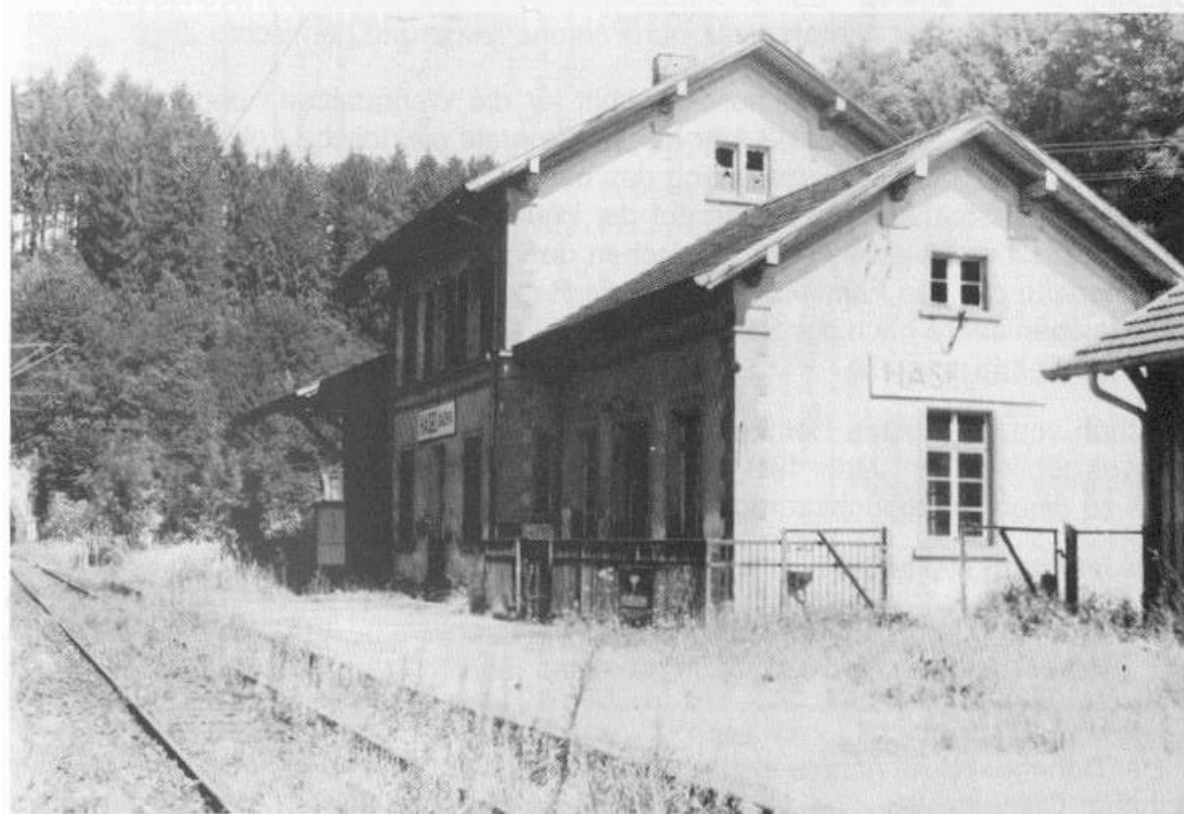
Bahnhofsgebäude Hasel (Baden) (Foto: Gerber)
